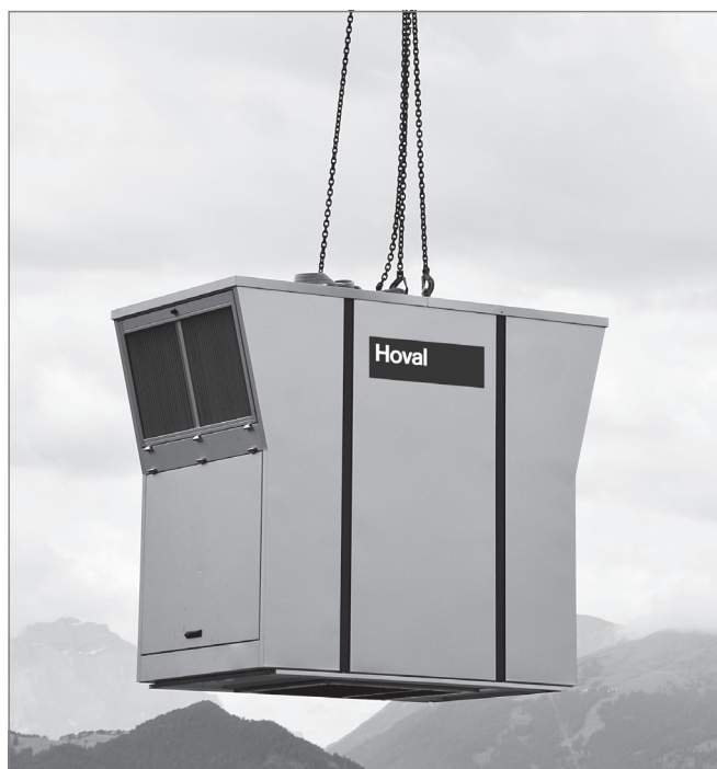
Obrázek F6: Zvednutí nástřešní jednotky pomocí našroubovaných přepravních ok
