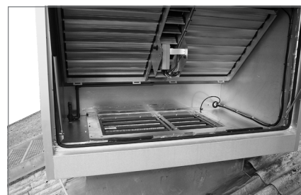
Obrázek 33: Filtr odváděného vzduchu
