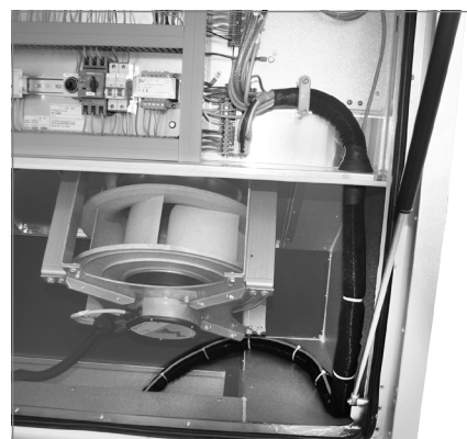
Obrázek 31: Upevnění kabelového svazku
