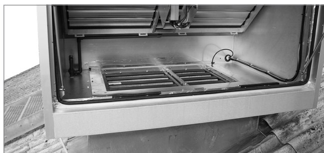
Obrázek 25: Filtr odváděného vzduchu nainstalován na jednotce
